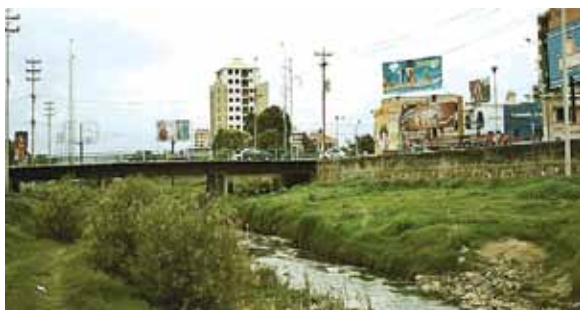
Fotografía 9 Puente de la Recoleta 2008
