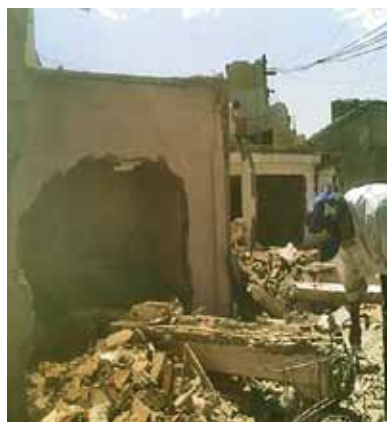
Demolición de viviendas por relocalización de familias
