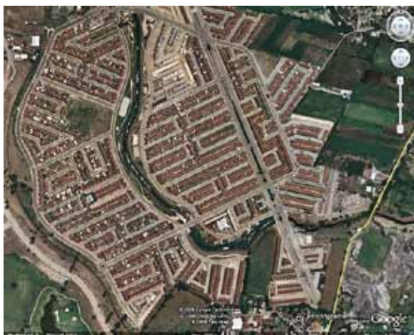
Unidad Morelos, Xochitepec, 7.900 viviendas.
